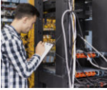
IT panolarında, Server rack kabinlerinde,
